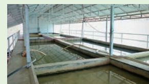
浄水施設の建築・メンテナンス等
