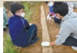
三和土の設置に加え、 グリーンベルトとしてベ チバーを植えることで、 より赤土等流出防止の 効果が期待できる
