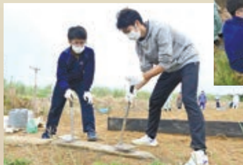
三和土の設置に加え、 グリーンベルトとしてベ チバーを植えることで、 より赤土等流出防止の 効果が期待できる
