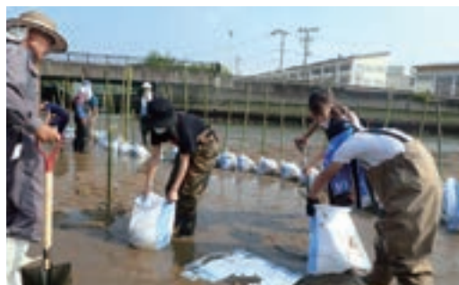
竹で水の流れを調整したが、豪雨で竹が流されてしまうというトラブルに見舞われた
