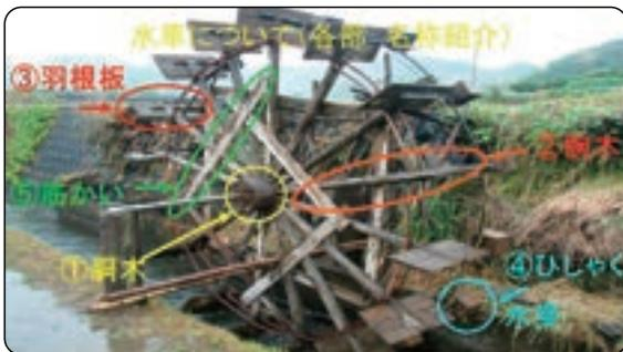
水車製作にあたり、①地元の間伐材を使用 ②地域住民と共同作業で行う。この2点を受け継ぎながら作業を進めた。しかし大きな問題に直面した。その一つが水車の中核ともいえる胴木である。胴木は水車の中心であり、芯棒を貫通させて水車全体を回す最も重要な部分である。しかし使用材料は、地元の間伐材を伐
