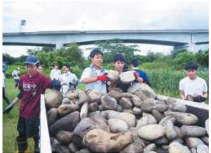
ト二面張りの実験河川に、高校生でも運べる大きさの石を積みむことにした。それにより、川の流れを変えて砂や泥などを川底に堆積させ、継続的に手を加えなくても、可能な限り自然発生的に多様な河川環境が出来上がる石の置き方を検証したのである。
