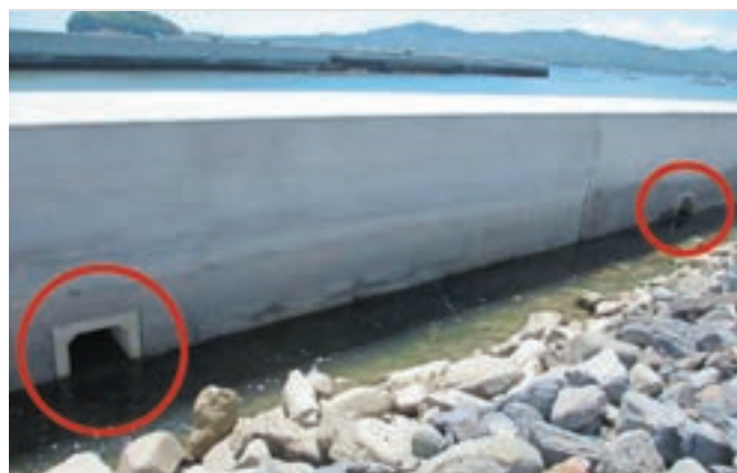
生徒たちの活動もあって、完成した導流堤には川と干潟をつなぐパイプが設けられた。
