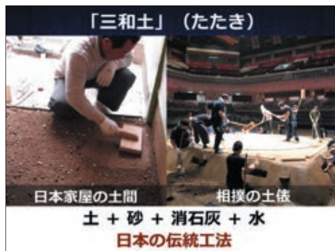
伝統工法として広く用いられてきた三和土。外国の土で三和土を作るための配合も研究した。
