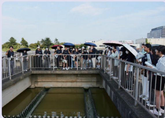
千葉市南部浄化センターで下水処理の工程を学びました
